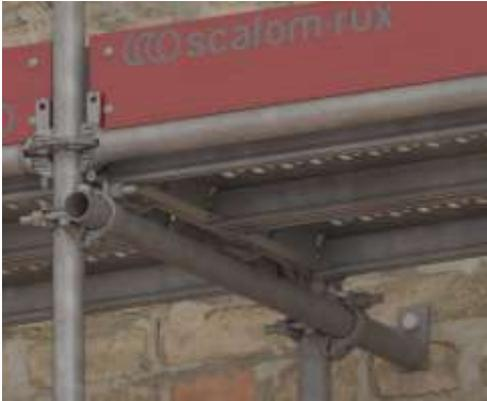
Figure 6.2c : Exemple de dispositif d'attache
