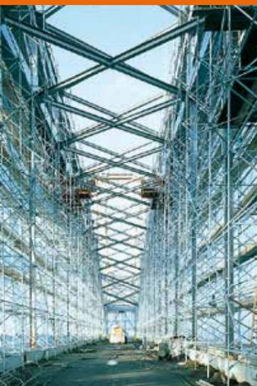
48,3 mm ou 1,5 pouce : c'est la seule dimension, la dimension universelle en matière d'échafaudages. Qu'il s'agisse d'échafaudages modulaires, de cadres dans les échafaudages de façades, de brides supérieures ou inférieures dans les poutres en treillis, de tubes d'échafaudage en acier ou aluminium, ils ont tous le même diamètre. Cela facilite l'usage d'accessoires d'échafaudage, aussi bien lors de la planification que lors de l'application.
