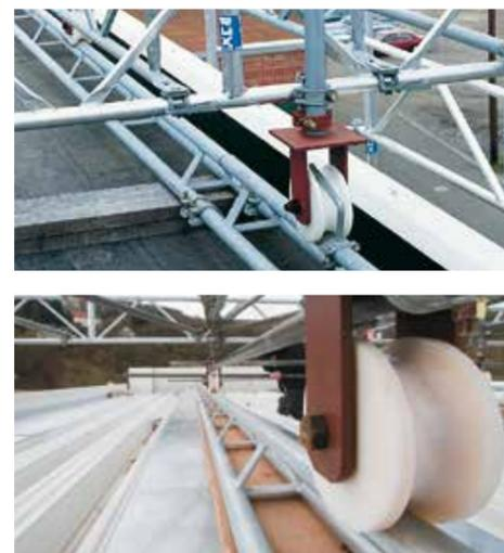
Dans de nombreux cas, les échafaudages mobiles sont une alternative extrêmement rentable par comparaison aux échafaudages complets, car ils vous permettent d'épargner beaucoup de temps lors de l'assemblage et du démantèlement.
